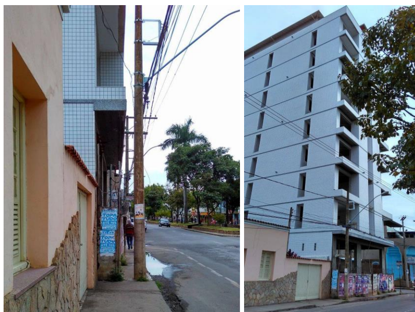
Figura 6 e 7 – Edificação localizada na Av. Leite de Castro: sem afastamentos frontais, laterais e sem vagas de garagem. Detalhe para o avanço da edificação sobre o passeio, bem próximo a fiação elétrica. Foto: dos autores.
